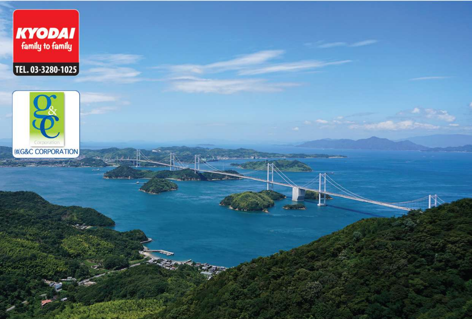
Autopista Shimanami entre Hiroshima y Ehime.
